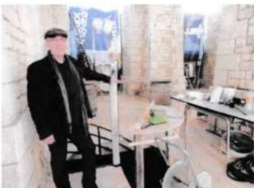
Michel Becker à l'intérieur du site en travaux, devant l'emplacement du futur bar.
