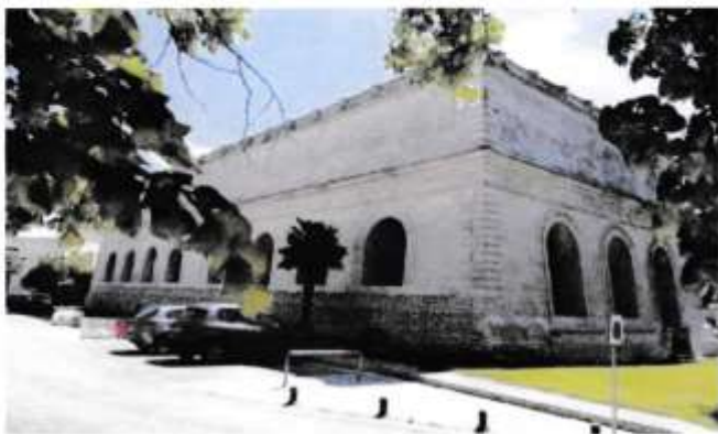
L'association a déjà engagé bien des travaux : ravalement et nettoyage du toit, entre autres. N. A. C.
